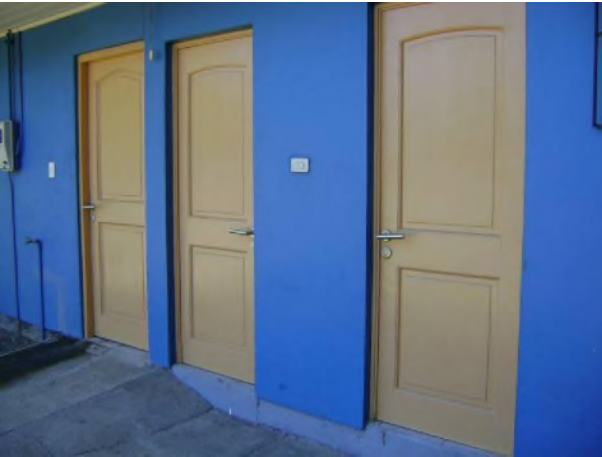
Reparación de vano y cambio de puertas de las 4 postas
