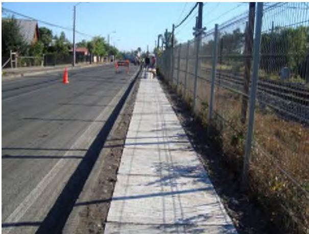
PROYECTO PMU Construcción Veredas y Soleras Calle General Cruz entre ruta Q-50 y calle Florida Inversión $27.821.000 - Avance 100 %
