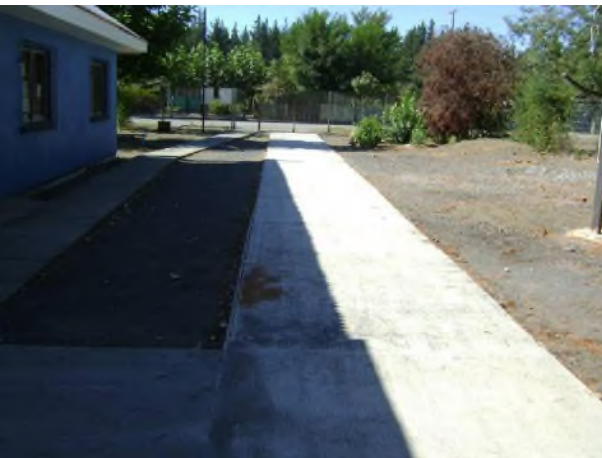
Reparación de acceso vehículos Rondas Médicas
