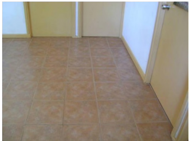
Reparación piso de las 4 Postas con instalación de cerámicos
